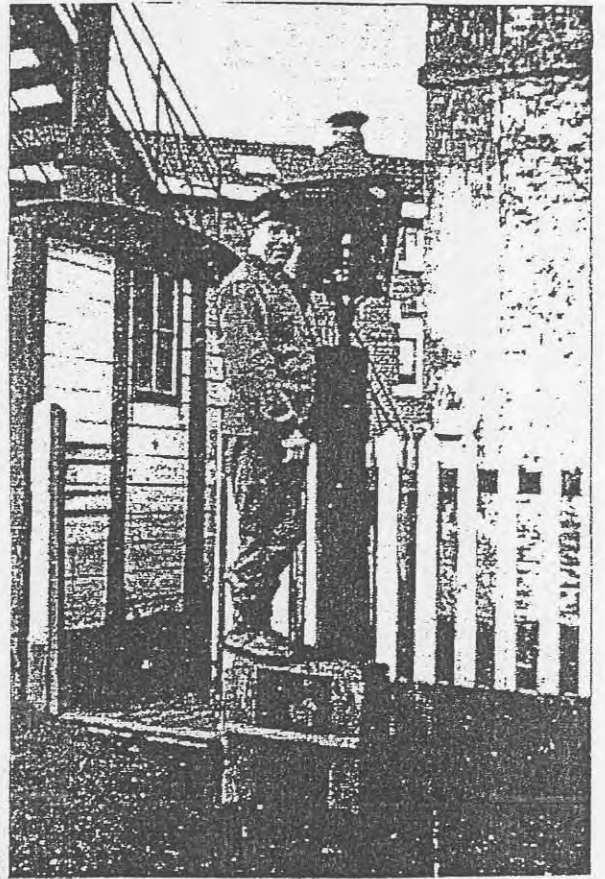
1949: François Bourguignon allume la lanterne du quai. A gauche, un bout de la caisse du wagon servant d'abri (coll. des auteurs).
